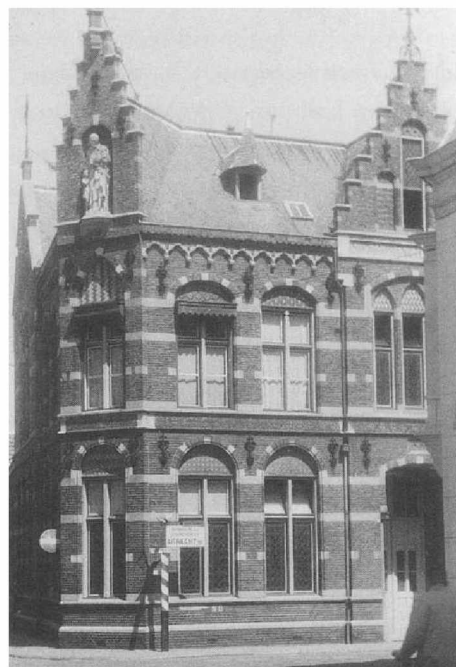
Het Broederhuis aan de Arendstraat (Foto: Collectie 5.1,2,e ).
