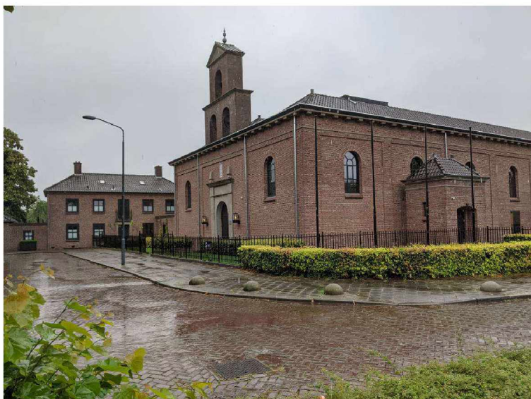
De Mariakerk in Oosterhout is herbestemd tot kantoorgebouw. Een mooi voorbeeld van de kansen die kerkgebouwen bieden.
